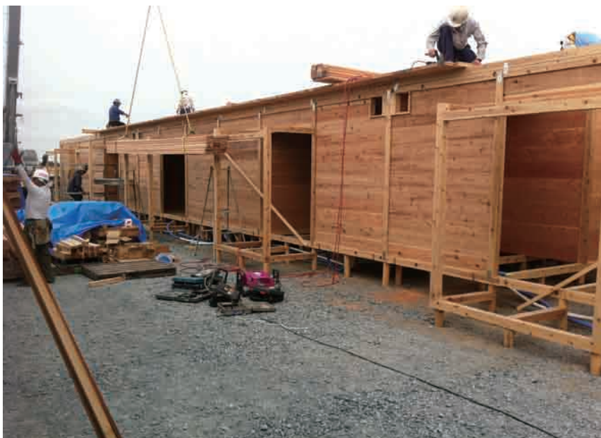
南相馬市の木造仮設住宅の建設現場。プレハブではなく、木造で4000戸近い戸数を建設中。
