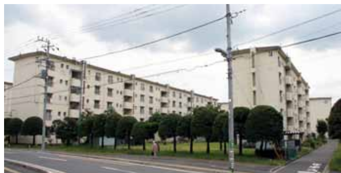
築 50 年近く経ち、老朽化した豊四季台団地。典型的な高度成長期の団地の建築スタイルで、エレベーターなしの 5 階建て
